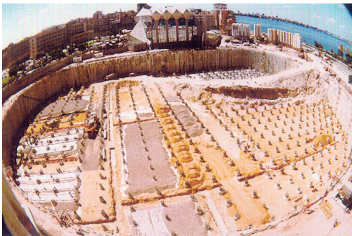
Vue du chantier après la mise en place des 600 piliers © B.A.
