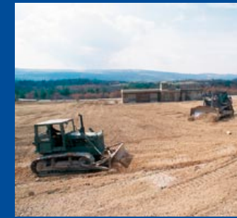
1998 : le démantèlement est presque terminé
