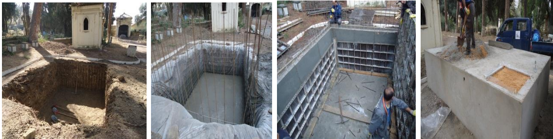
Construction d'un ossuaire
