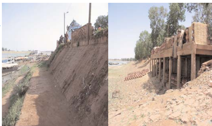
Quais et berges à reconstruire (photos : D.Roussel)
