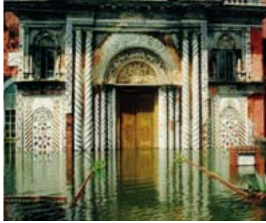
Façade inondée, cité de Panam-Sonargaon (XV e -XIX e siècle), Bangladesh, 2004. Site sur la liste 2008 des 100 sites les plus menacés du WMF. Crédit : World Monuments Fund.
