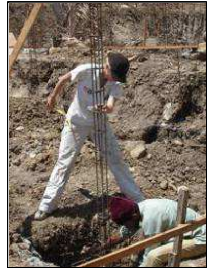
Chantier sur l'île de Weh
